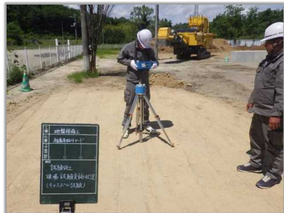
簡易支持力測定状況
