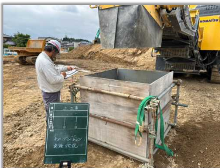
キャリブレーション実施状況
