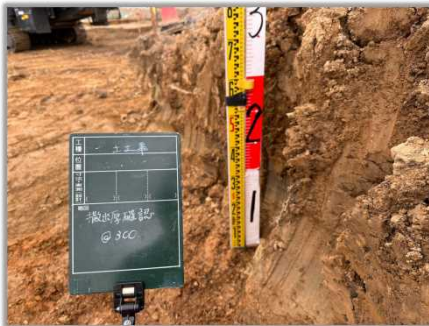
撒き出し厚確認
