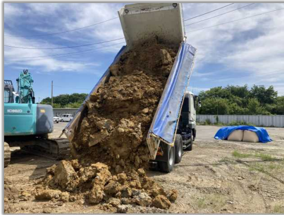
原料土搬入状況
