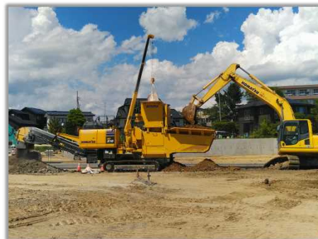
固化剤・原料土投入状況
