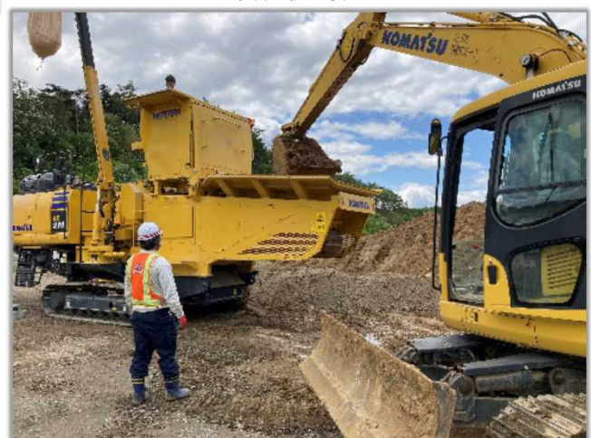
原料土投入状況
